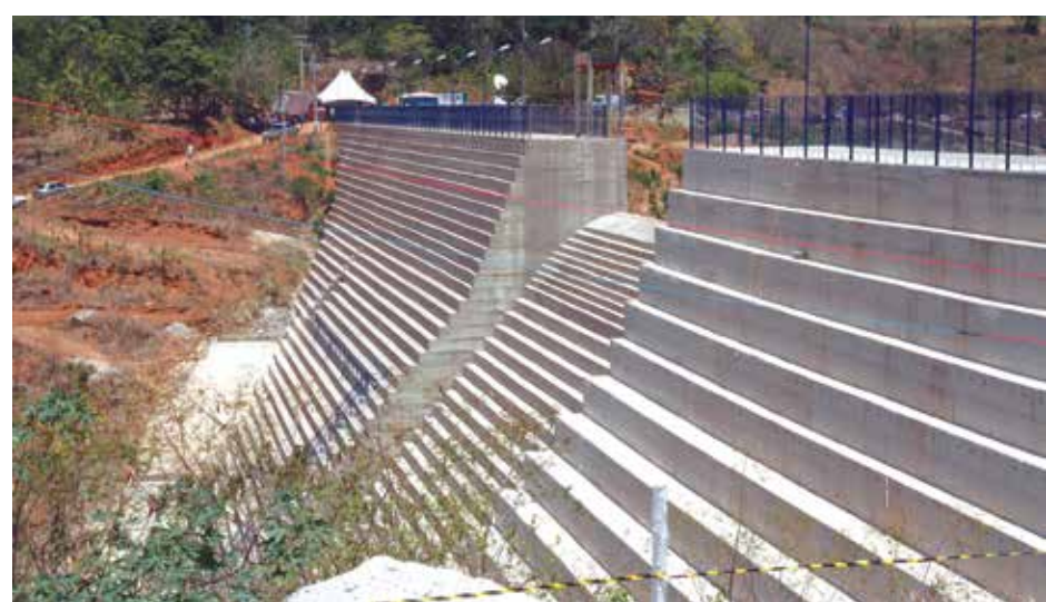
Barragem Nova Camará vai beneficiar população em 20 cidades paraibanas
